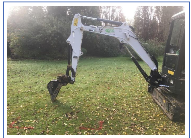
Mini digger used on site
